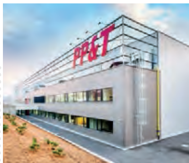
▶ Výrobní hala PP&T, Linhartice přípojnice Zucchini, rozváděčové skříně XL 3 4000, výkonové jističe DPX 3 , modulární přístroje
