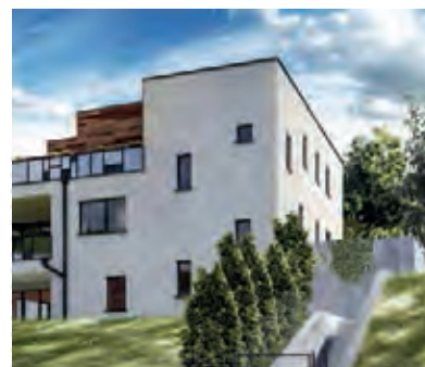
► Bytový dům La Crone, Praha modulární přístroje
