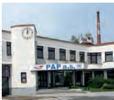
► Výrobní hala Dopla PAP, Sušice přípojnice Zucchini, rozváděčové skříně XL 3 4000, vzduchové a výkonové jističe DMX 3 a DPX 3
