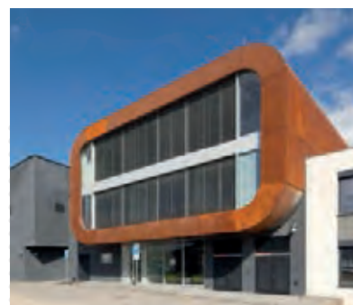
► Datové centrum DataSpring, Lužice distribuční transformátory EdM, přípojnice Zucchini
