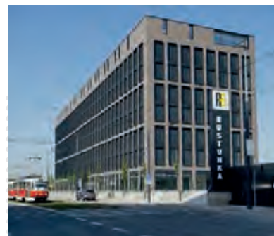
▶ Administrativní budova Rustonka, Praha distribuční transformátory EdM, přípojnice Zucchini, výkonové jističe DPX 3 , modulární přístroje, podlahové krabice
