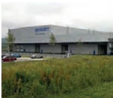
► Výrobní hala Benteler, Klášterec nad Ohří přípojnice Zucchini, vzduchové a výkonové jističe DMX 3 a DPX 3 , modulární přístroje
